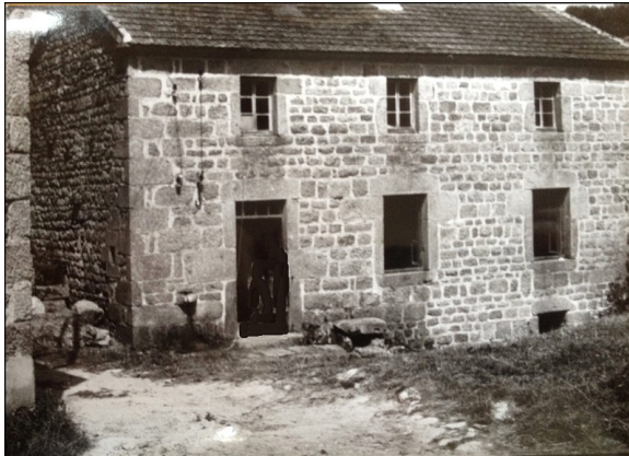
La maison dans son état en 69.
